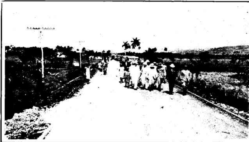
Obras de la carretera central, próximas a su terminación.
